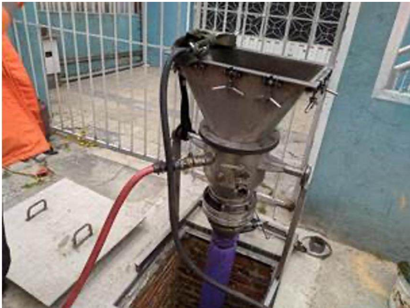
Rehabilitación conexiones domiciliarias.
