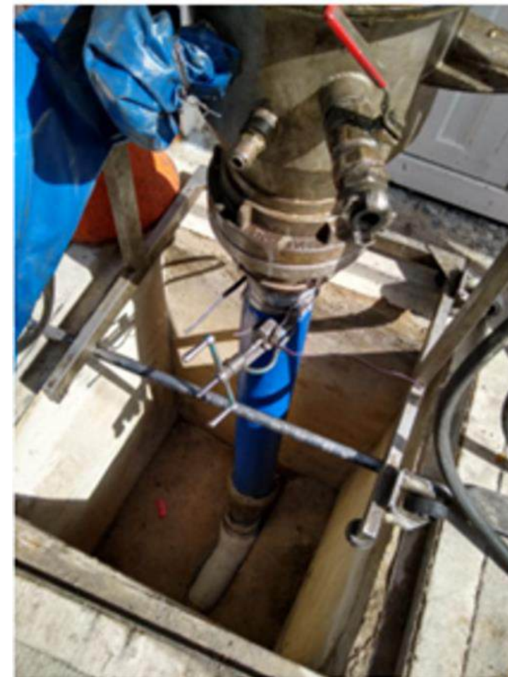
Rehabilitación conexiones domiciliarias.
